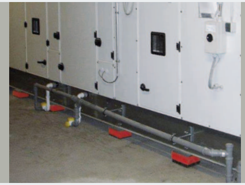
Pružně izolovaný AHU systém
