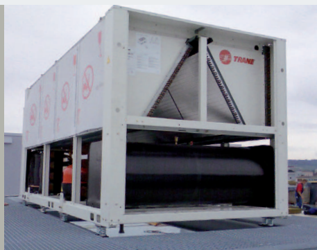
Speciální pružné uložení klimatizační jednotky
